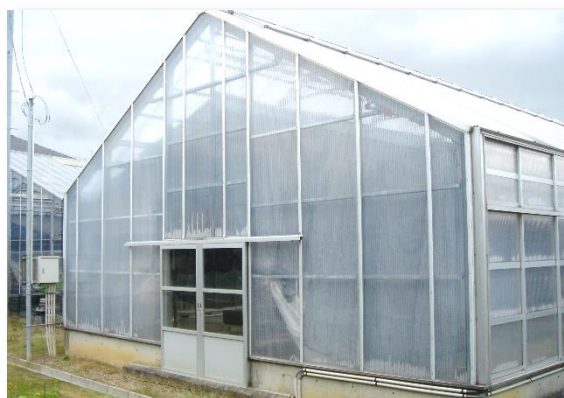
プラスチックハウスⅤ類 (鋼材又はアルミ材骨格・合成樹脂板被覆)
