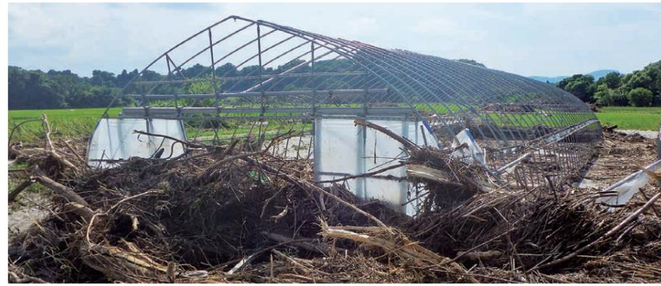
強風が見込まれ、本体の被害を軽減するために事前に被覆材を切除する場合は、必ず組合にご連絡ください。
