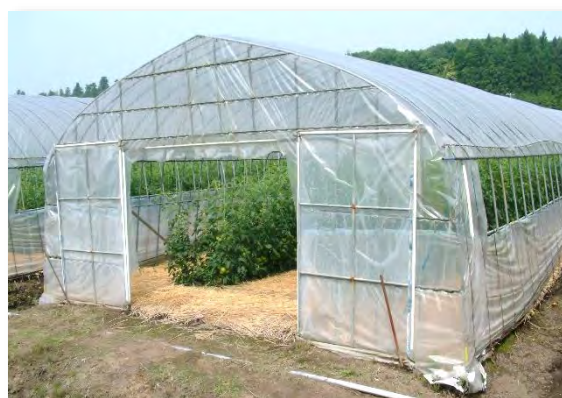
プラスチックハウスⅡ類 (パイプ材骨格)
