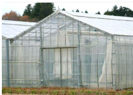
プラスチックハウスⅣ類 甲・乙 (鋼材又はアルミ材骨格・軟材又は硬質フィルム被覆)
