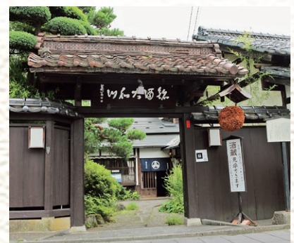
▲喜多方らしく趣き深い北方風土館
