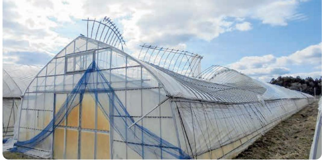
春は強風が吹きやすく、多くのハウスに被害が発生する季節です。近年では、竜巻やダウンバースト、ガストフロントが原因とみられる風害や、春先のひょう害も発生しています。
